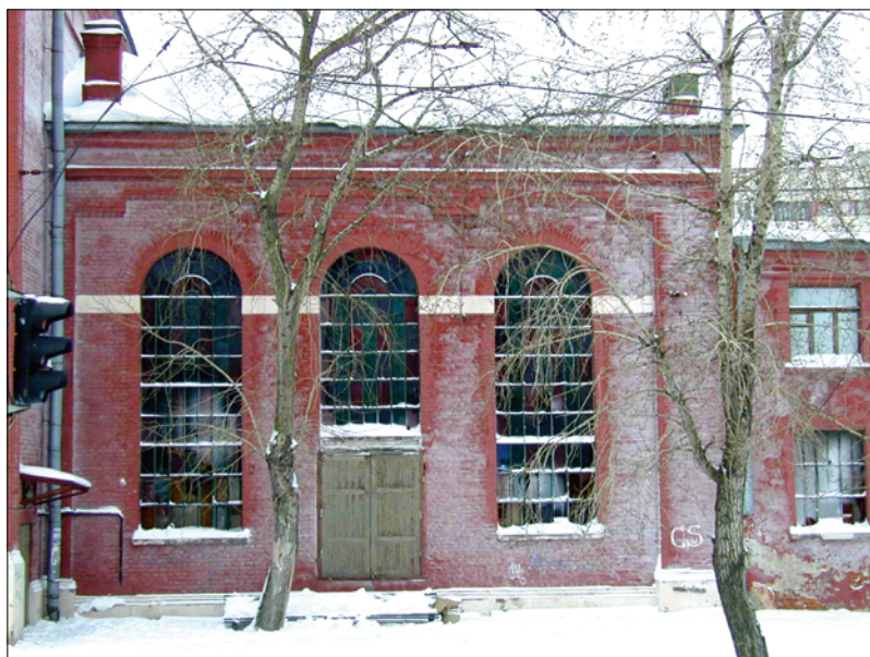
Окна машинного зала до ремонта (фото ООО «Ганзейский союз»)
